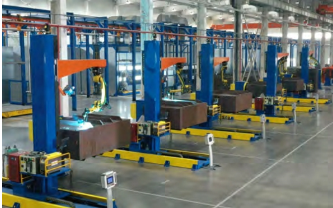
Fuel tank welding workshop Цех сварки топливных баков
