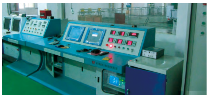
Transformer experiment automatic test monitoring systems Автоматические системы мониторинга испытаний трансформаторов
