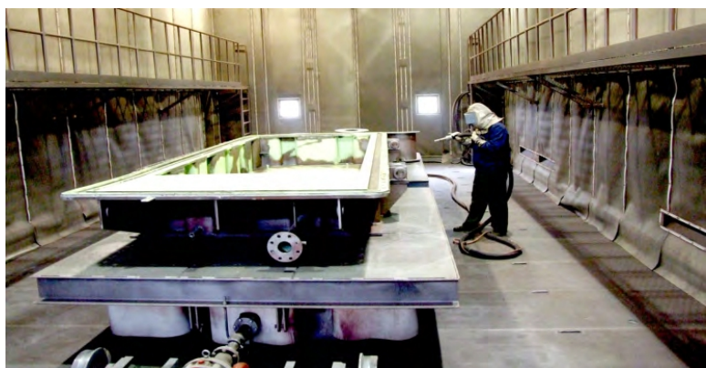
Transformer tank shot-peened equipment Оборудование для дробеструйной обработки трансформаторных баков.
